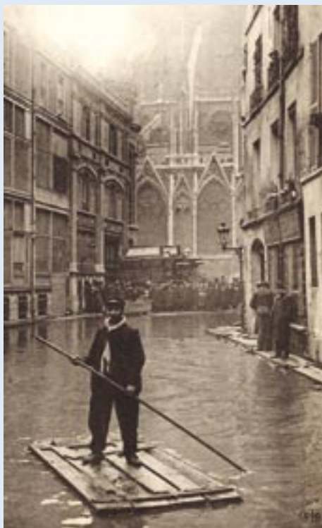
Inondation de Paris en 1910, rue Massillon
