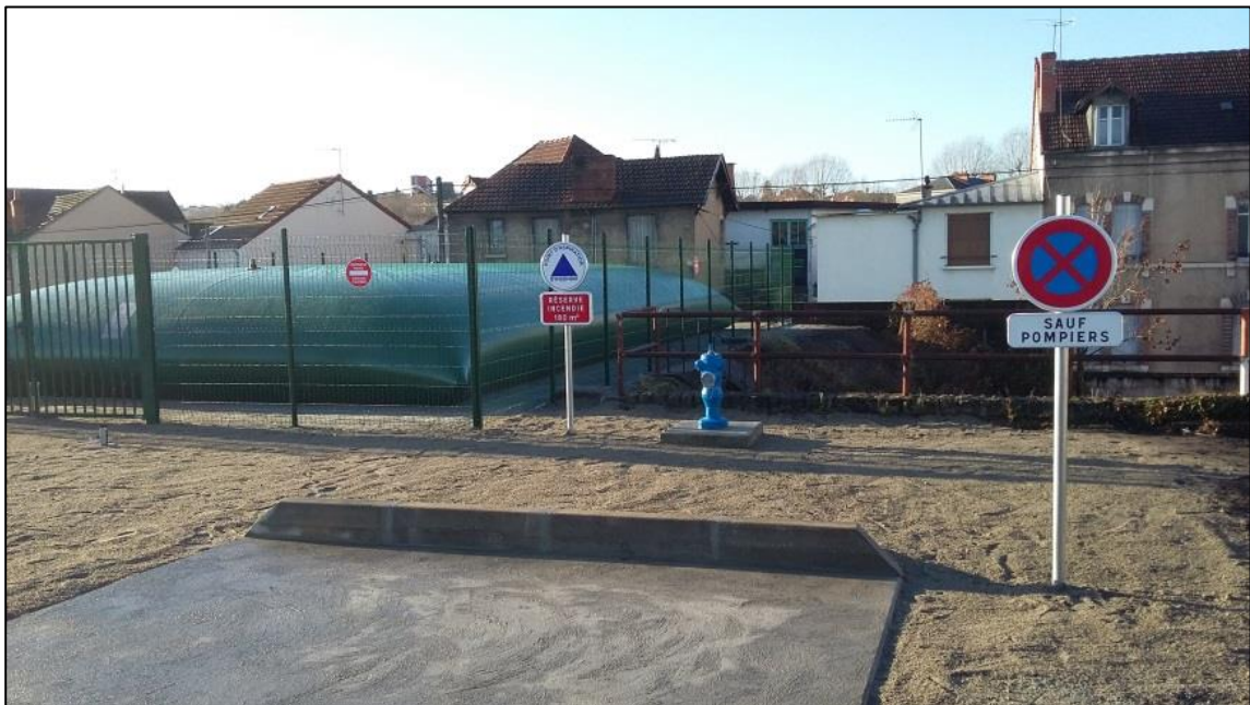
Arrêt et stationnement interdit sur une aire d'aspiration matérialisée
