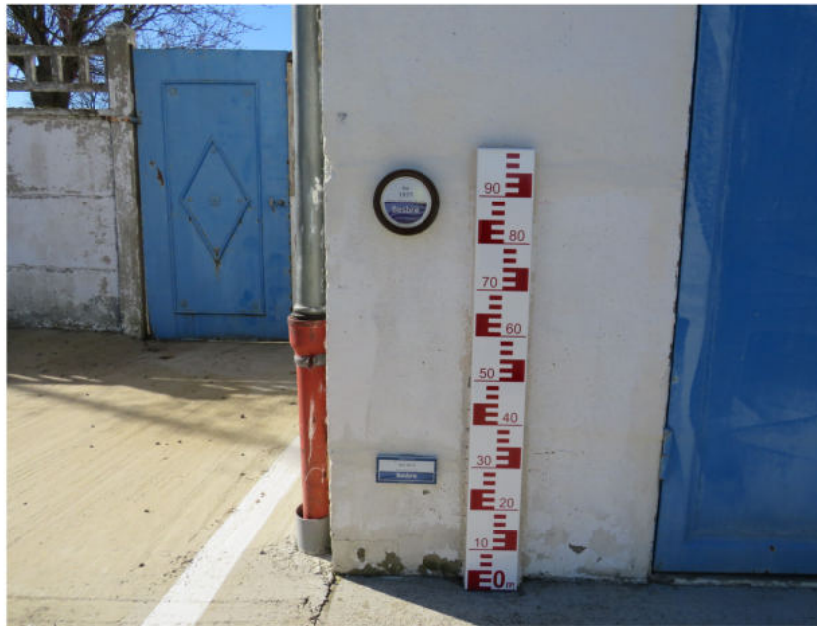
Repères de crue et échelle de mesure au stade municipal de Dompierre-sur-Besbre (Source DDT 03)
