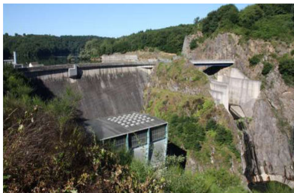
Barrage de Rochebut (Source Wikipédia)
