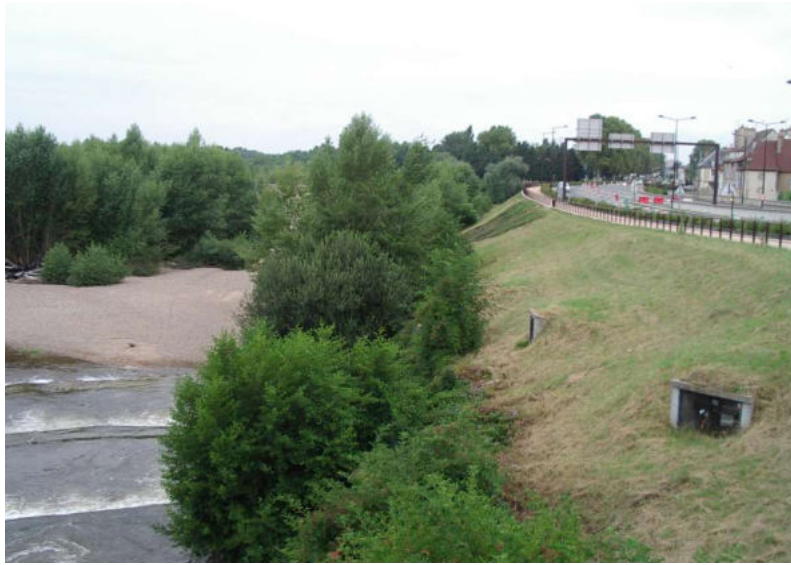
Levée des Gâteaux, rive droite de l'Allier à Moulins (Source : DDT03)
